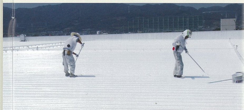
屋根からの侵入熱を大幅にカットする『クールサーム』の塗装作業
