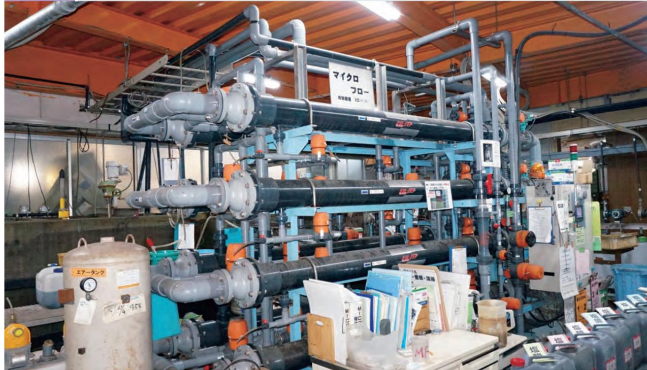
排水処理のための精密ろ過装置
