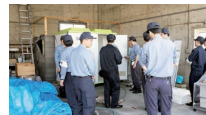
熊本刑務所での設置現場
