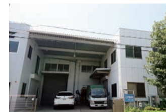
「7ヶ燃機」を導入した第2工場
