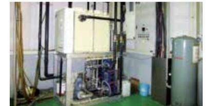
密閉式冷却水循環システム
