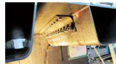
工場試験施工の状況
