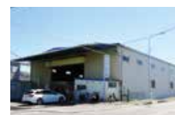
本社工場の外観
