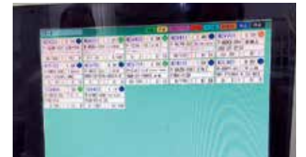
稼働状況を表示するモニター
